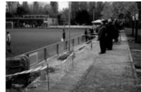
Sobald der erforderliche Bauantrag genehmigt ist, wird die 18 Meter lange Stahlkonstruktion auf dem abgesperrten Bereich errichtet.
