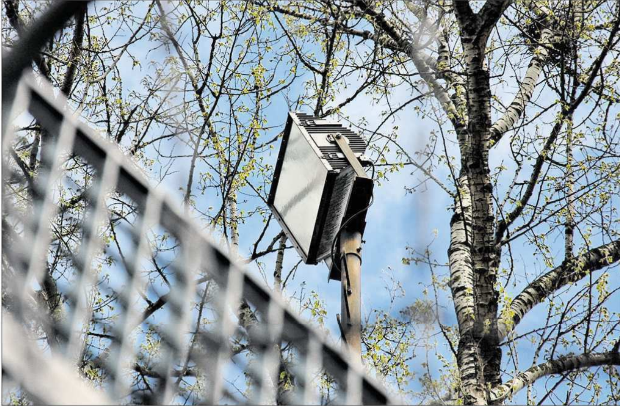
Die Flutlichtanlage an der Grundschule Grasdorf ist seit Anfang 2012 stillgelegt.
